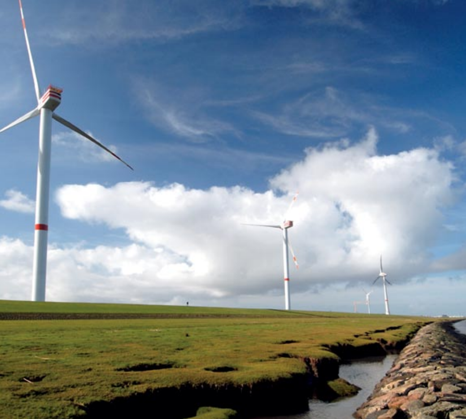
5 MW windturbine, Cuxhaven
