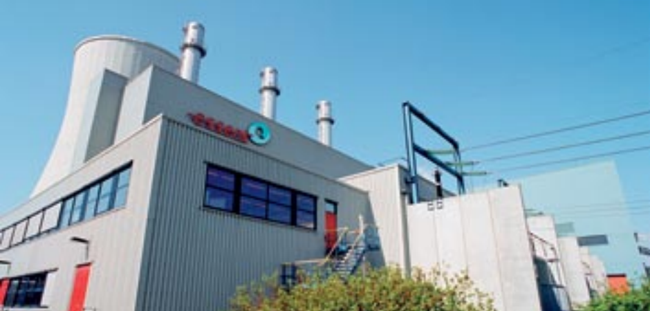
Warmtekrachtcentrale, WKC Moerdijk
