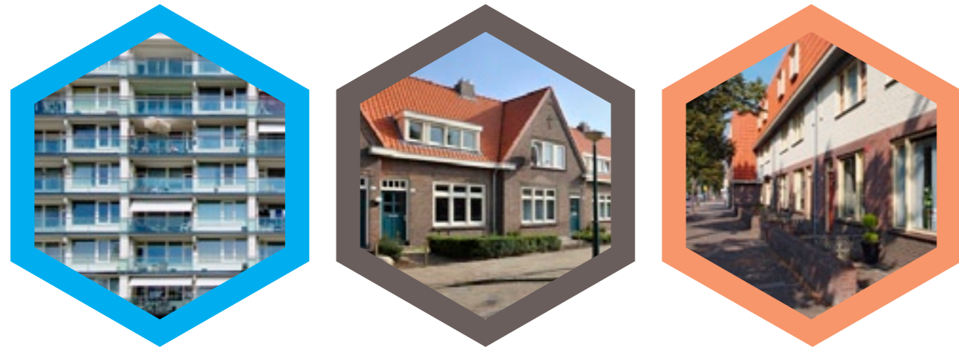
Renovatie 4 flatgebouwen in de Brusselstraat in Breda in opdracht van WonenBreborg Renovatie Drents Dorp in Eindhoven in opdracht van het Woonbedrijf Renovatie Oerlesestraat en omgeving in Tilburg, 109 woningen in opdracht van Tiwos
